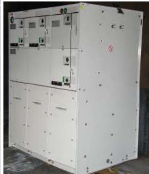
После испытания на дугу с ликвидатором электрической дуги
