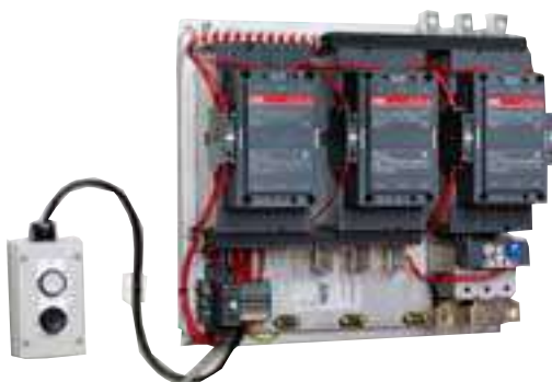
Пуск переключением со звезды на треугольник
